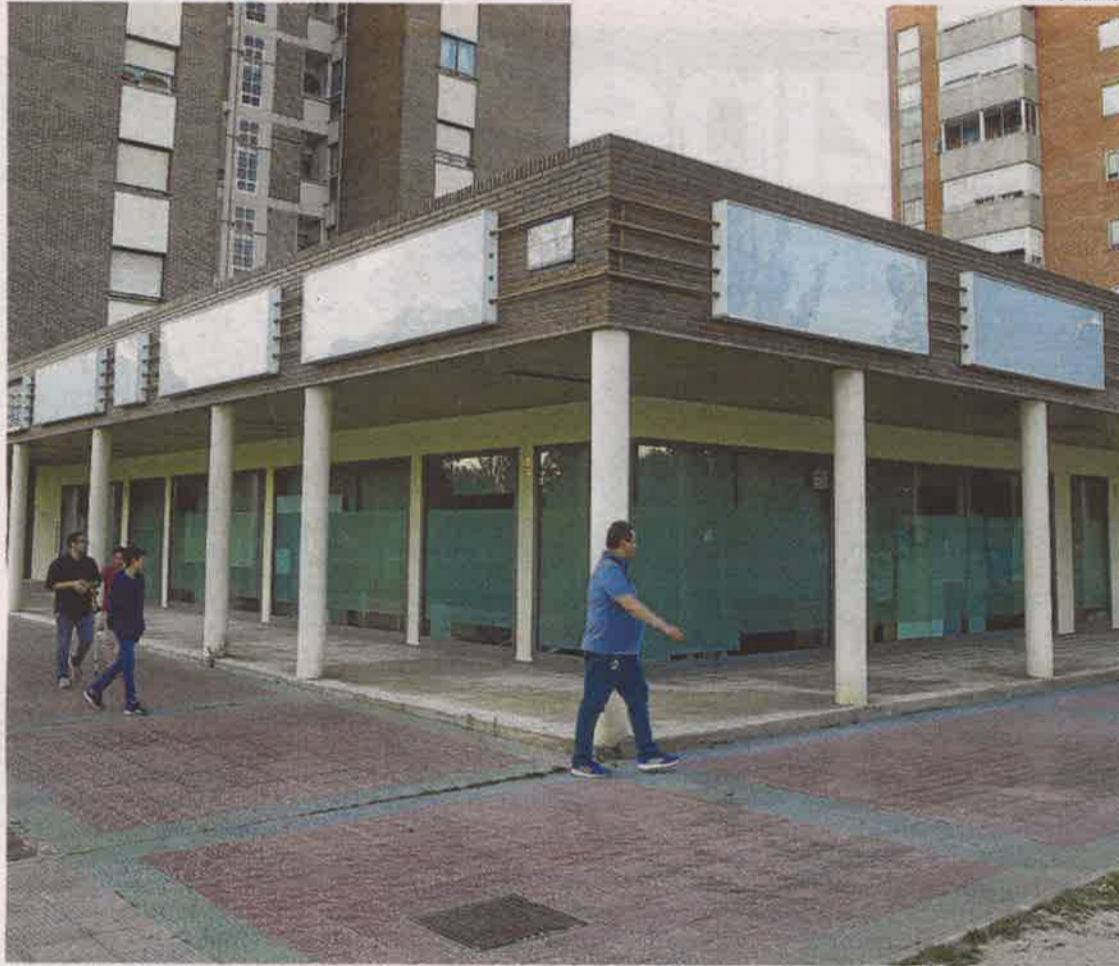
La sede. Las oficinas de las empresas implicadas estaban en la calle Carlos Marx del Actur.
